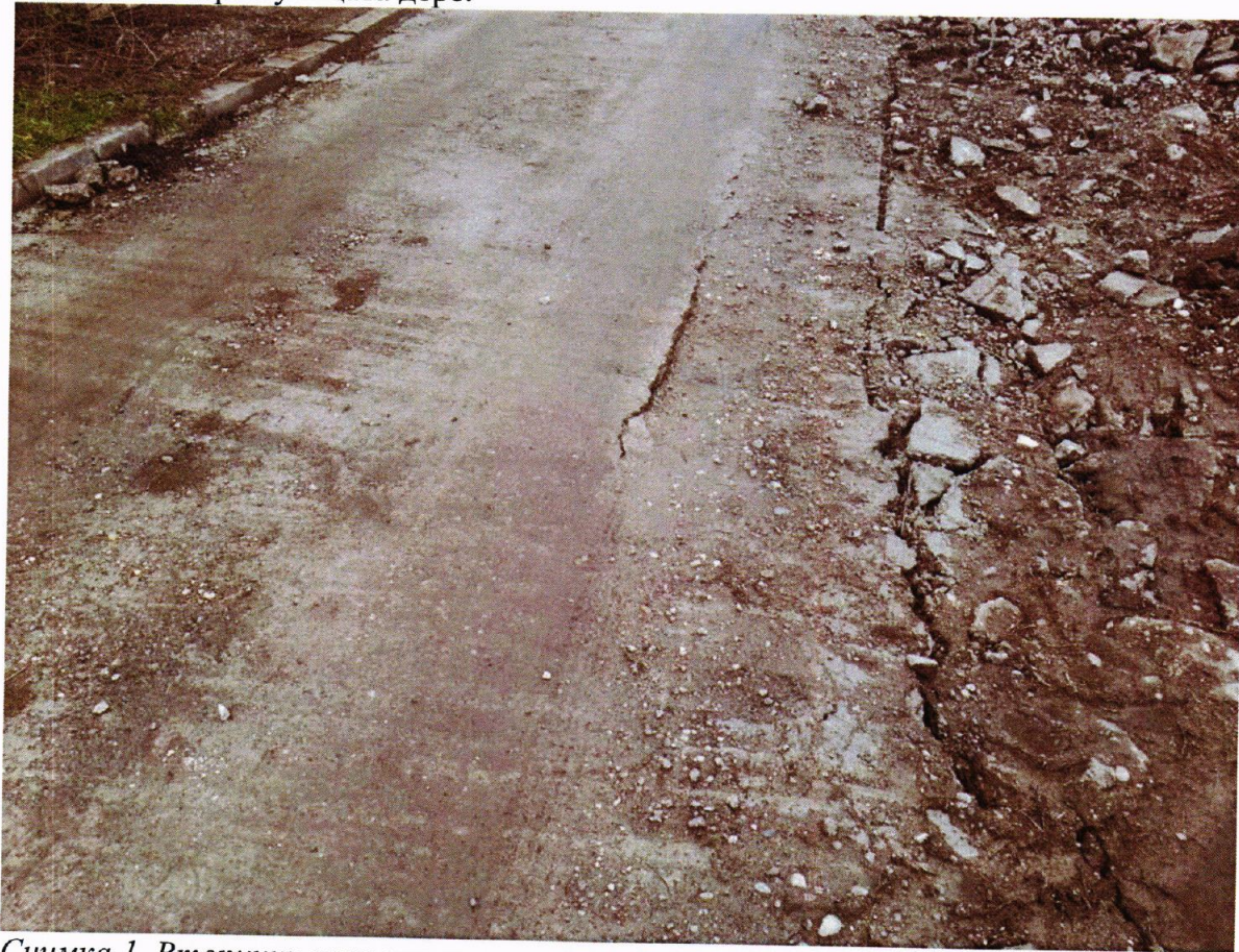
Снимка 1. Вторични пукнатини и компрометиран пътен насип
